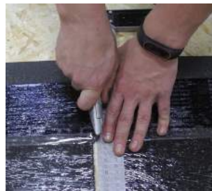
Рис. 77. Деление плитки на лепестки
