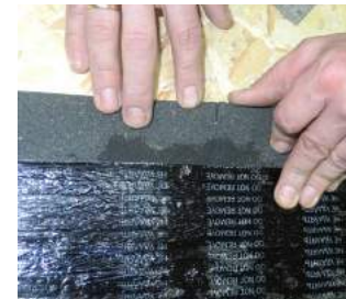
Рис. 76. Насечка для облегчения монтажа
