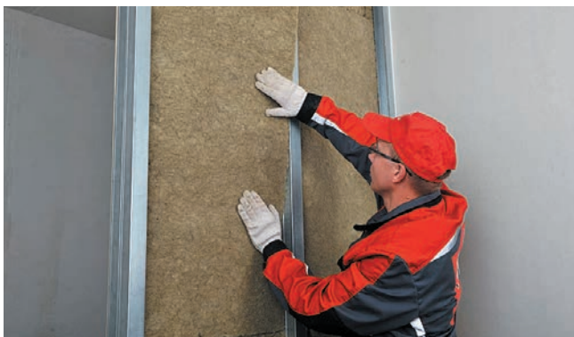
Рис. 6. Монтаж тепло-, звукоизоляционных плит
