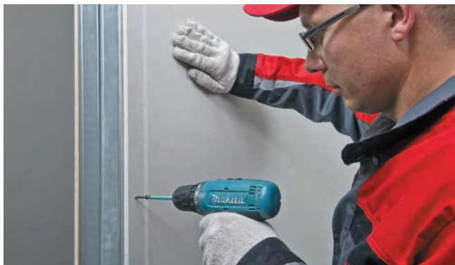
Рис. 13. Обшивка стен листами ГКЛ
