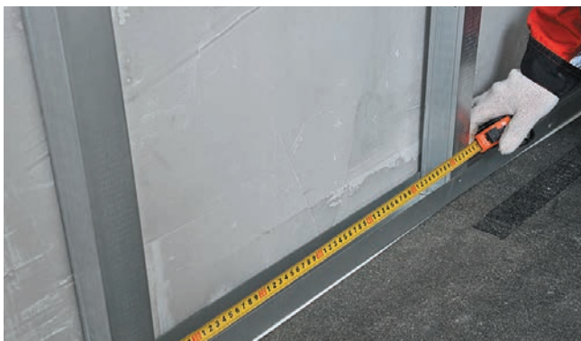
Рис. 11. Установка направляющего и стойчного профилей
