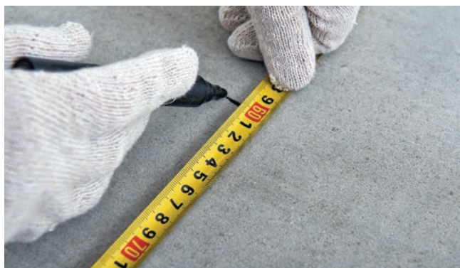
Рис. 2. Разметка основания
