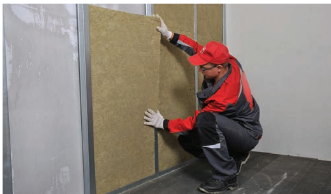
Рис. 12. Монтаж тепло-, звукоизоляционных плит
