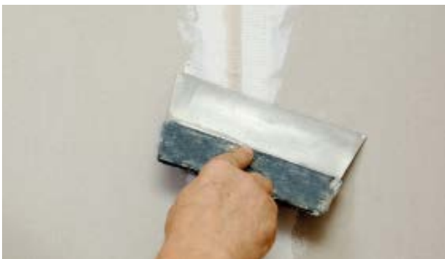
Рис. 8. Заделка швов
