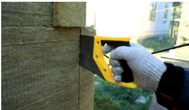
Рис. 10. Зубчатая перевязка плит на наружных углах здания
