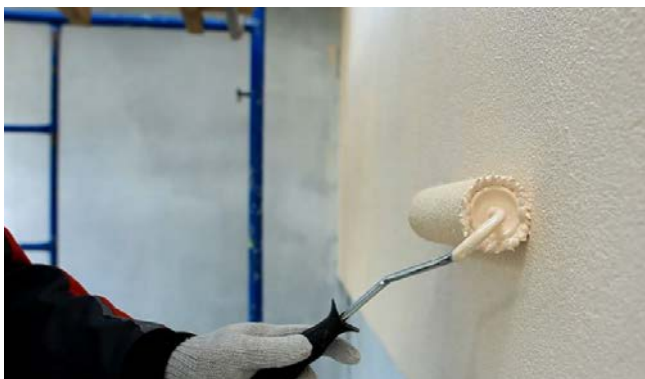
Рис. 19. Нанесение краски на поверхность фасада
