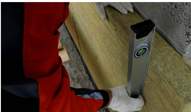
Рис. 8. Приклейка плиты тепло-, звукоизоляции к стене
