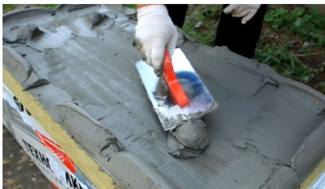
Рис. 6. Нанесение клея на плиту контурно-маячковым методом приклейки
