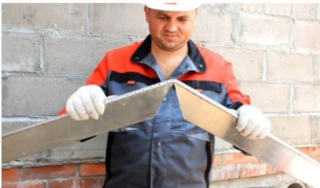
Рис. 2. Установка опорного профиля для первого ряда теплоизоляции
