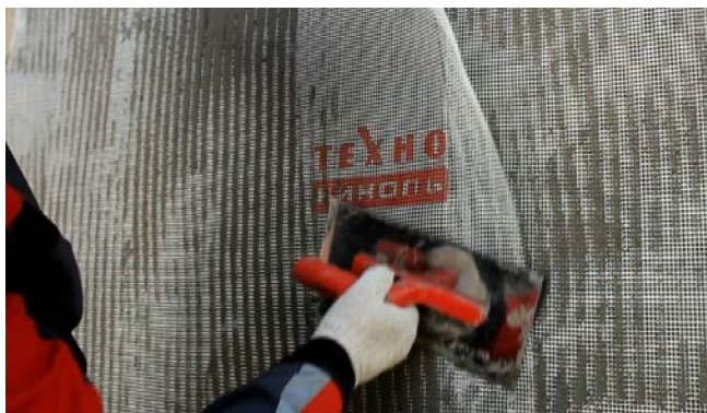
Рис. 16. Монтаж базового штукатурного слоя, армированного стеклосеткой
