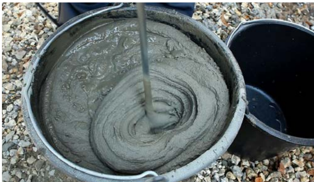
Рис. 3. Замешивание клея для приклейки теплоизоляции
