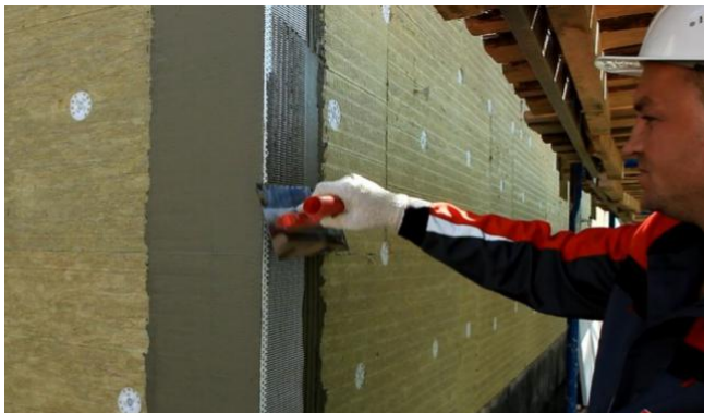
Рис. 15. Установка усиливающих профилей на углах здания
