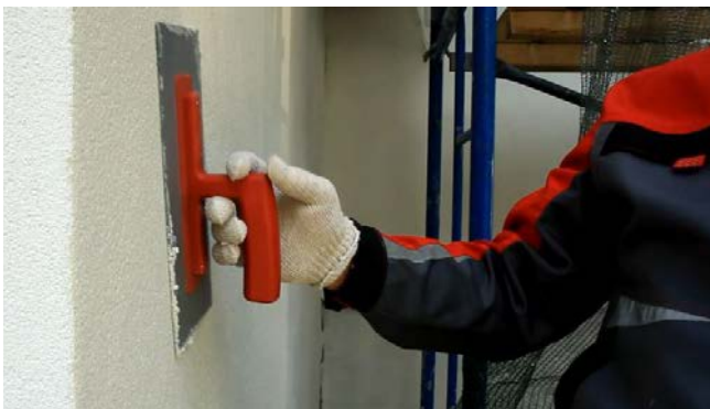
Рис. 18. Нанесение декоративного слоя штукатурки
