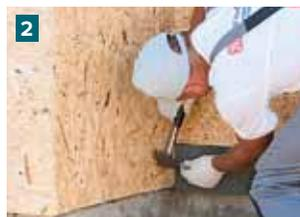
2 Монтаж стартовой полосы ведите с угла дома с отступом 5–10 мм. Удалите защитную пленку, отрежьте нижние «лепестки» фасадной плитки и закрепите на оцинкованные гвозди.
