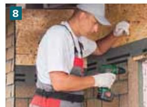
8 Для финишной отделки оконного проема используйте металлический оконный наличник. Монтаж ведется снизу вверх.
