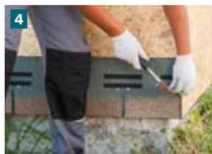
4 Части плитки, выходящие на внешние и внутренние углы дома подрежьте, отступив от угла 5–10мм.
